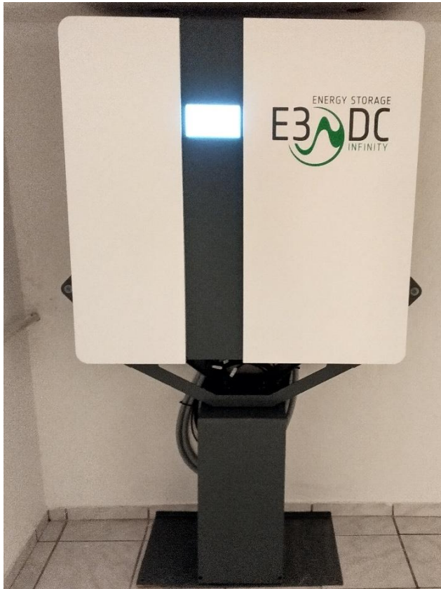
Abbildung 18: Beispiel für All-In-One Energiespeichersystem
